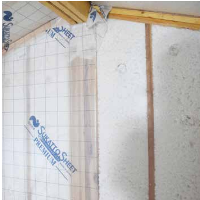
ブローイング工法断熱
