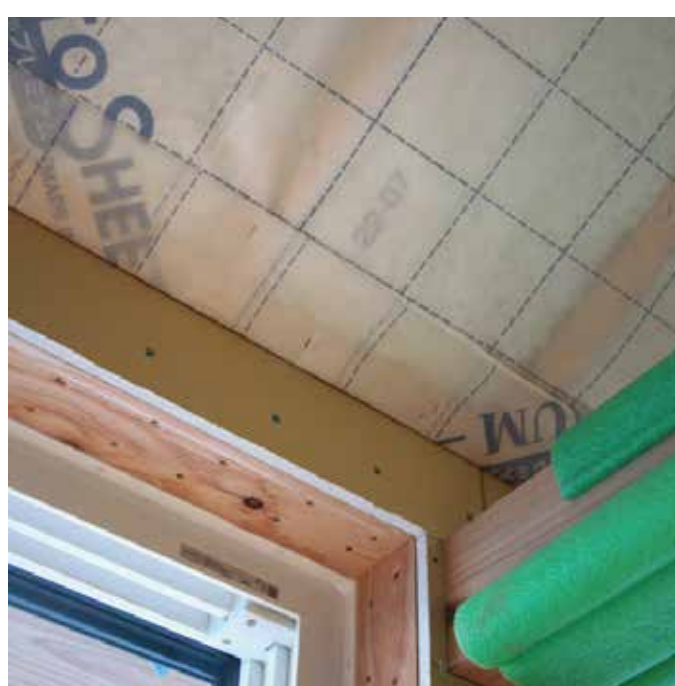
先貼り（天井部）
