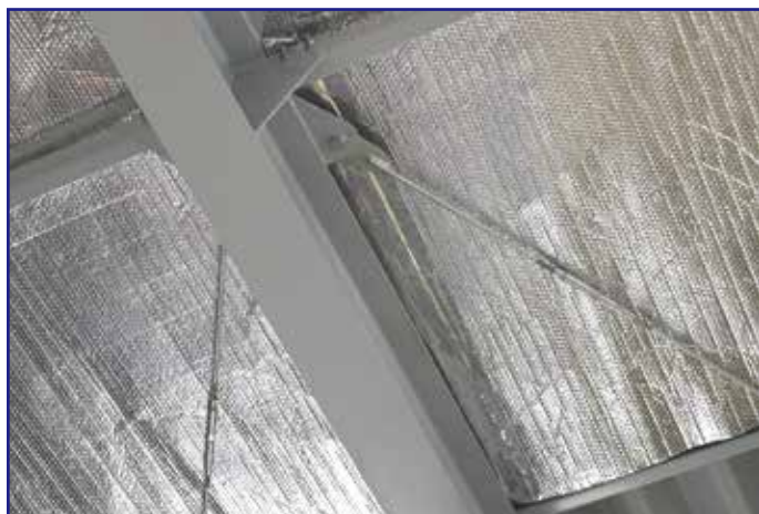
破れた場合はアルミテープで補修
