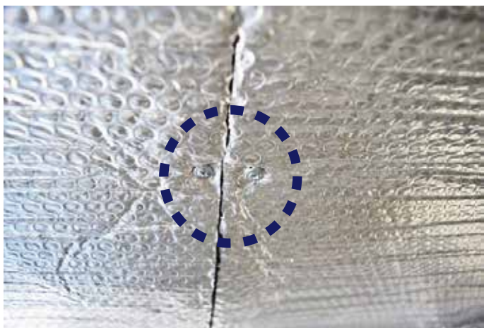
ロールの耳を合わせてビス止め
