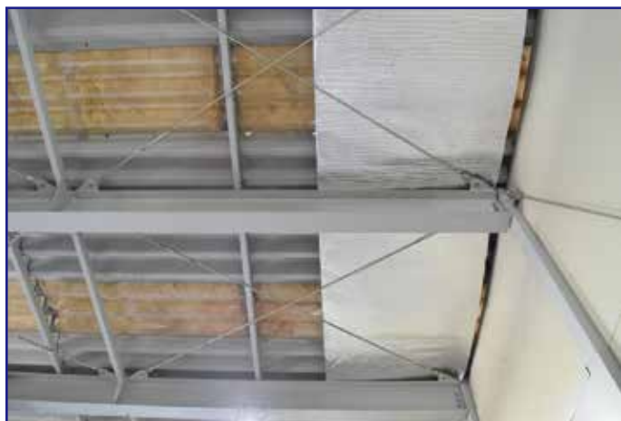
折板と梁(H鋼)・筋交いの間へ差し込み
