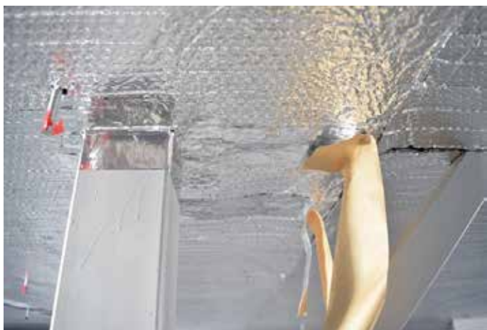
柱、電源コード周辺のアルミテープ貼り
