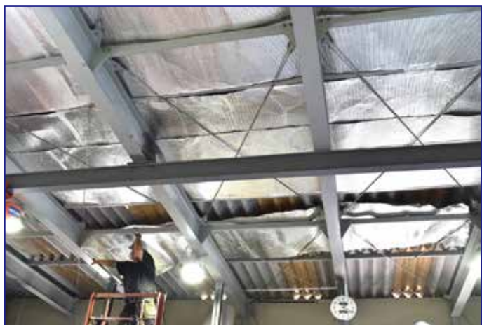
折板下へ差し込み
