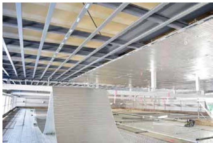
施工位置合わせて粗カット
