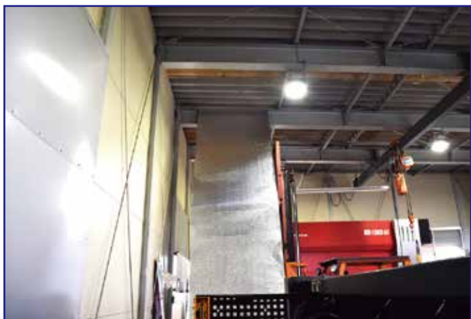
施工位置合わせして粗カット
