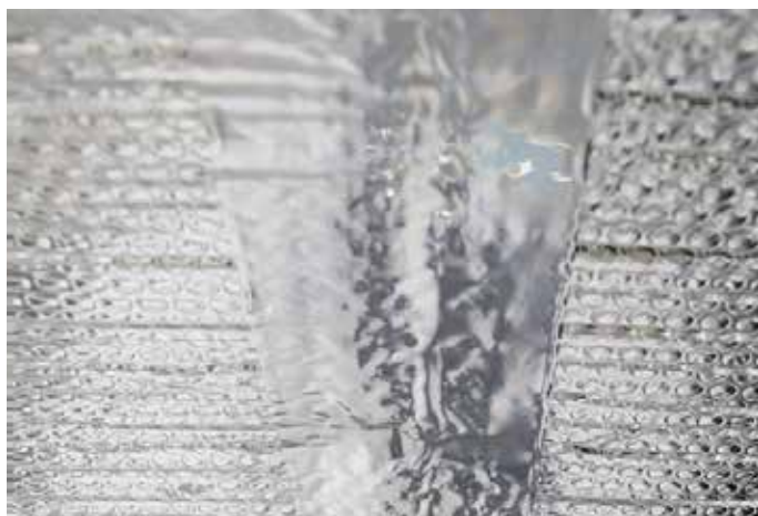
ロールの合わせ部にアルミテープ貼り
