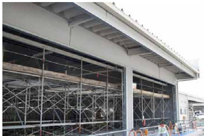
自動車整備工場、床から約 4.5m にラミパック SD を固定
