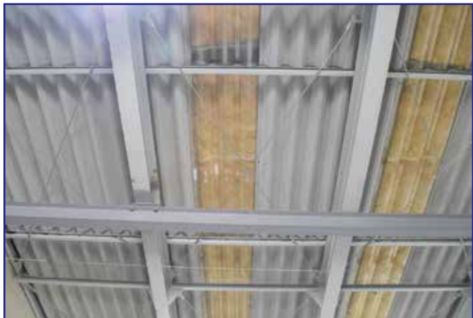
施工前 屋根カバー工法による2重折板屋根
